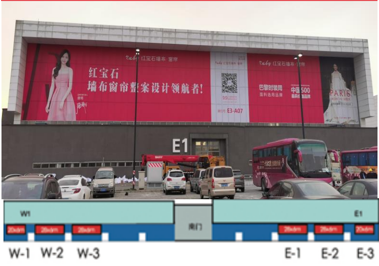
3.1-南广场南墙体
